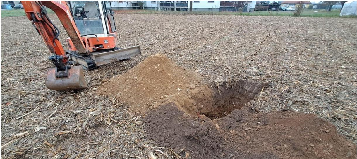
*Abbildung 5: Baggerschurf S03 mit Aushub*
